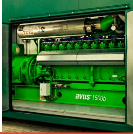
moteurs de cogénération.
